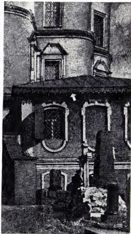
Подзоры (указаны стрелкой) ризницы (1748, арх. В. Обухов) Большого собора Донского монастыря в Москве.
